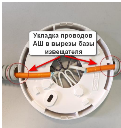
Рис. 2 Укладка проводов АШ со стороны монтажной поверхности базы извещателя
