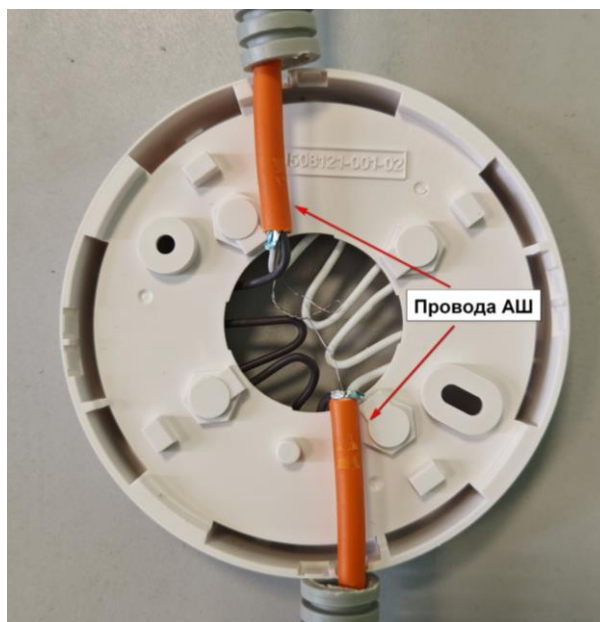
Рис. 5 Укладка проводов АШ со стороны монтажной поверхности базы извещателя
