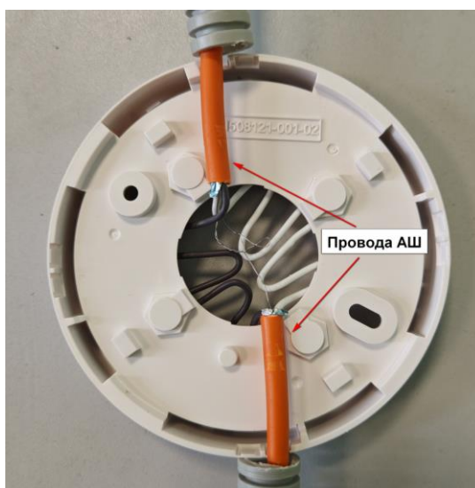
Рис. 6 Укладка проводов АШ со стороны монтажной поверхности базы извещателя
