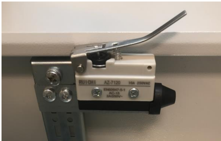
Рис.3.10. Регулировка металлического коромысла датчика
