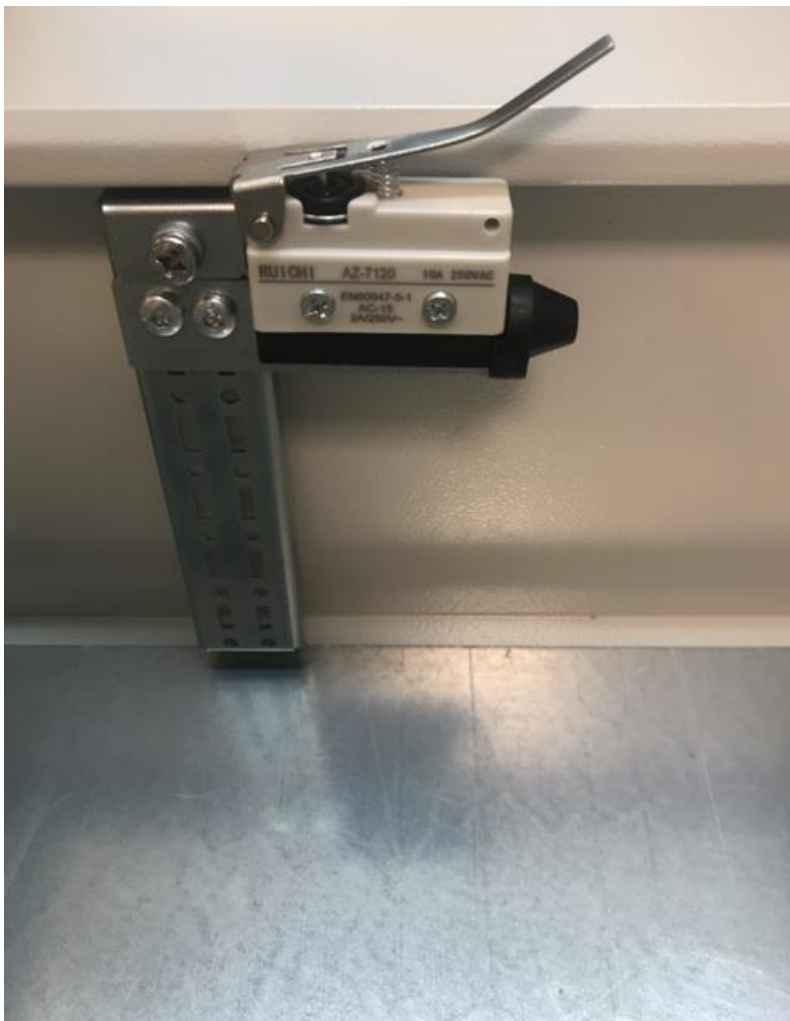
Рис.1 Датчик вскрытия установлен в уличную станцию OS (металлический корпус).
