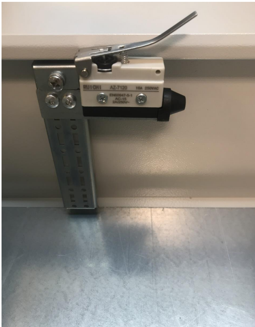
Рис.3.9 Установленная шина внутреннего монтажа с датчиком вскрытия
