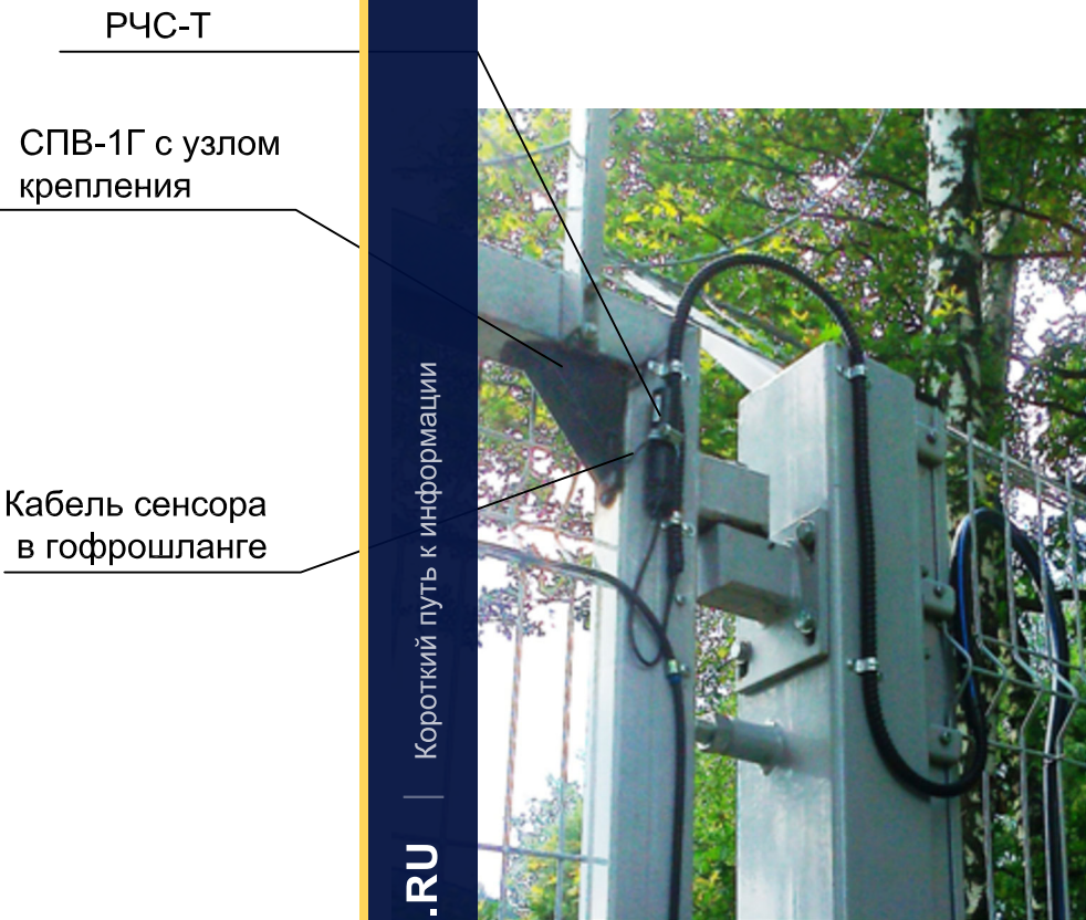
Фото 1. Размещение сенсора СПВ-1Г с узлом крепления и регулятора чувствительности сенсора на створке ворот.
