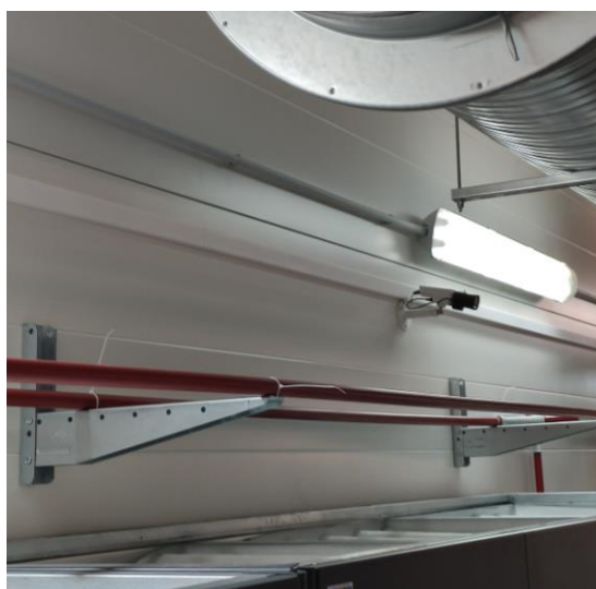
Рисунок 22 – Крепление труб на входе прецизионных кондиционеров на кронштейнах и на шпильках
