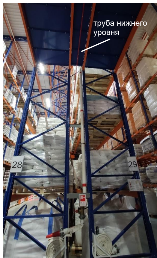
Рисунок 18 – Расположение труб нижнего уровня, под ярусами стеллажей
