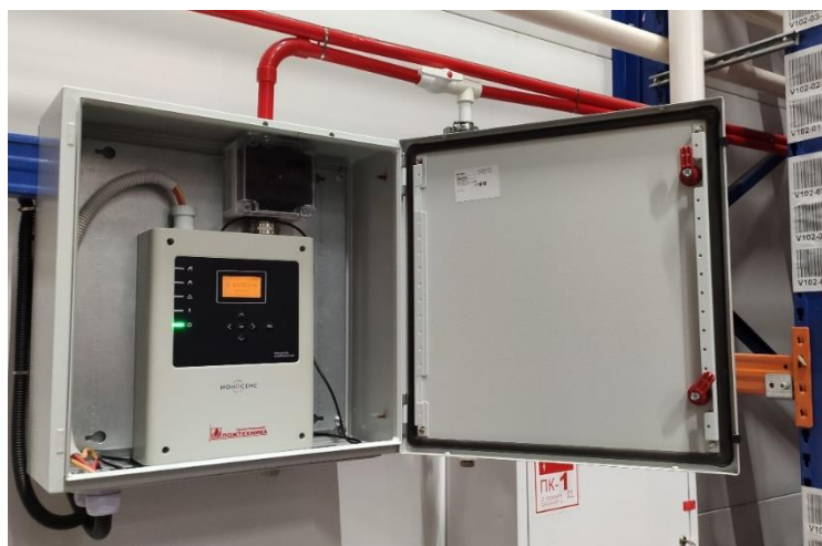
Рисунок 19 – Размещение серии «Ионосенс» в металлическом шкафу
