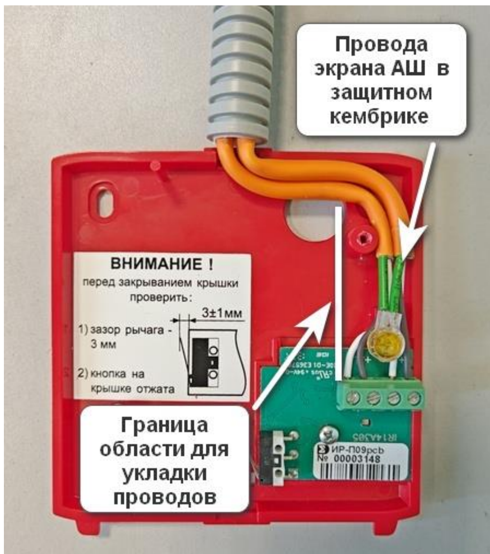
Рис. 8 Правильное размещение скотчлока внутри извещателя при подводке проводов сечением 0,75 \text{ мм}^2 через место выреза для кабеля на корпусе извещателя
