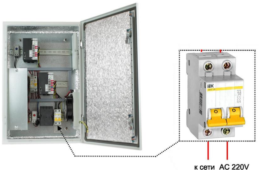
Рис.3 Точка подключения уличной станции OS-46PB1 к сети 220V переменного тока.
