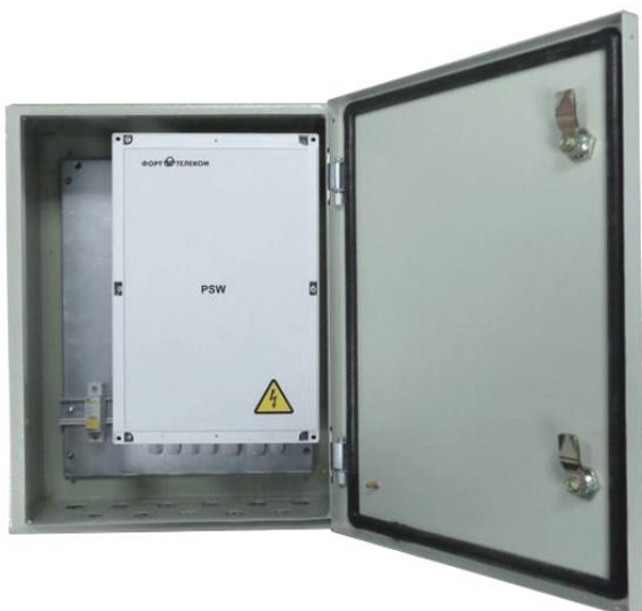
Рисунок 7.3 - Монтаж коммутатора в уличном шкафу.
