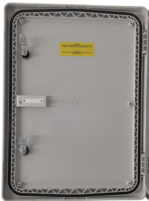
Рисунок 3.6.1 - Датчик вскрытия на крышке коммутатора
