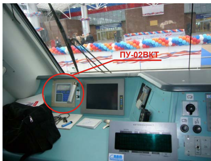
Рисунок 2. ПУ-02ВКТ в кабине электропоезда
