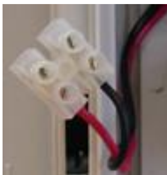
Рисунок 10. Кабель для подключения замка к блоку питания
