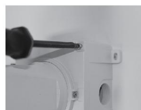
Закрутите винты коммутационной коробки
