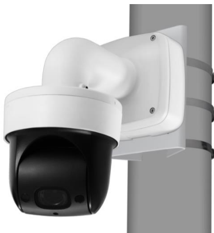
Рисунок 5.14 – Монтаж видеокамеры на столбовом кронштейне BR-103
